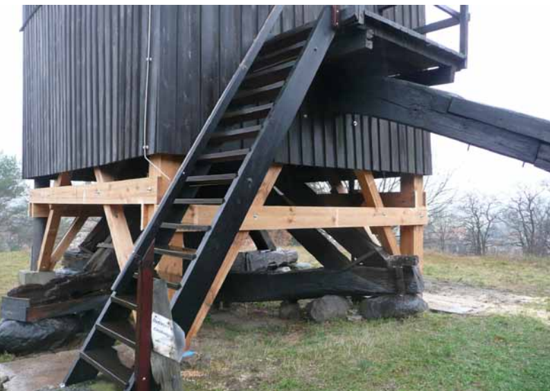
Provisorische Bockverstärkung
