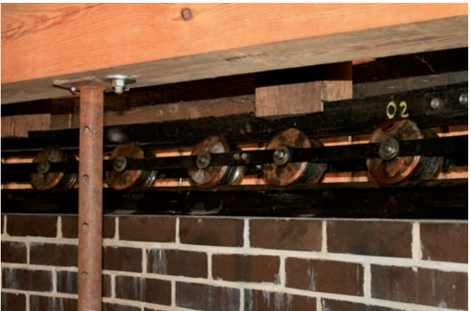
Rollenkranz der Paltrockwindmühle Oppelhain
