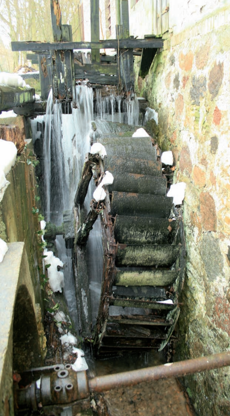
Oberschlächtiges Wasserrad an der Mühle Lemke, Hennickendorf östlich von Berlin
