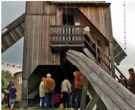
Sterz an der Bockwindmühle in Ketzür
