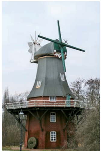
Holländerwindmühle Foline mit bereits abgenommenem Flügelkreuz, März 2009
