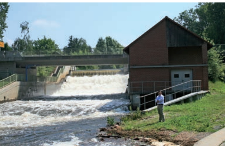
Wasserkraftanlage Märkisch Buchholz
