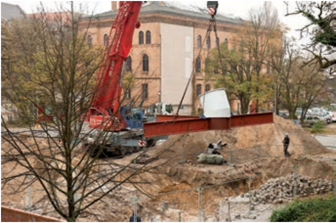
Vorbereitung zur Installation des Rotorblatts
