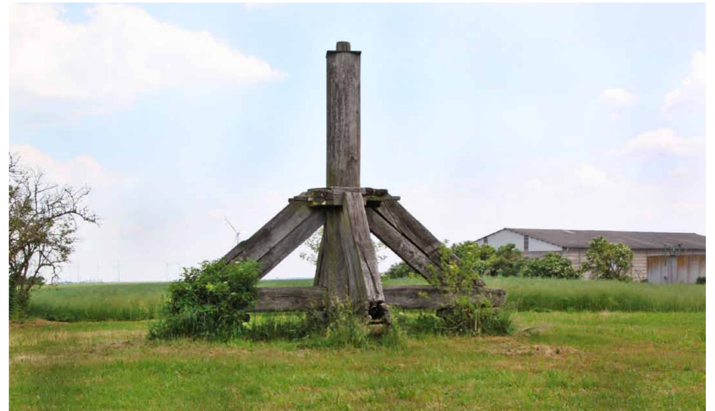
Der Bock als Rest der ehemaligen Bockwindmühle (Foto: Koska)
