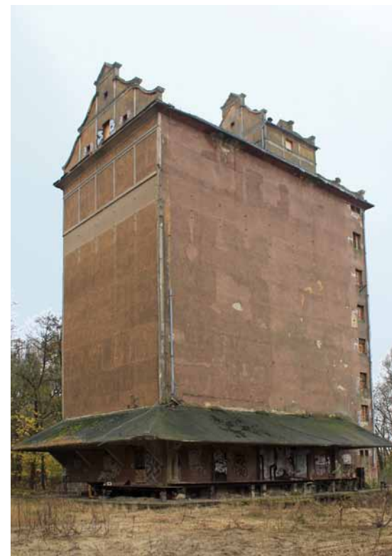
↓ Ehemaliger Getreidespeicher Oranienburg
