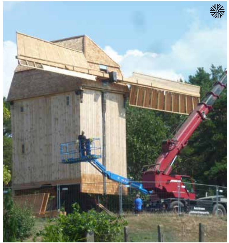
↑ Montage des Flügelkreuzes
