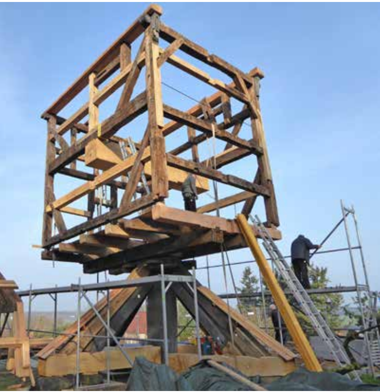
↑ Restaurierungsarbeiten am Fachwerk des Kastens
