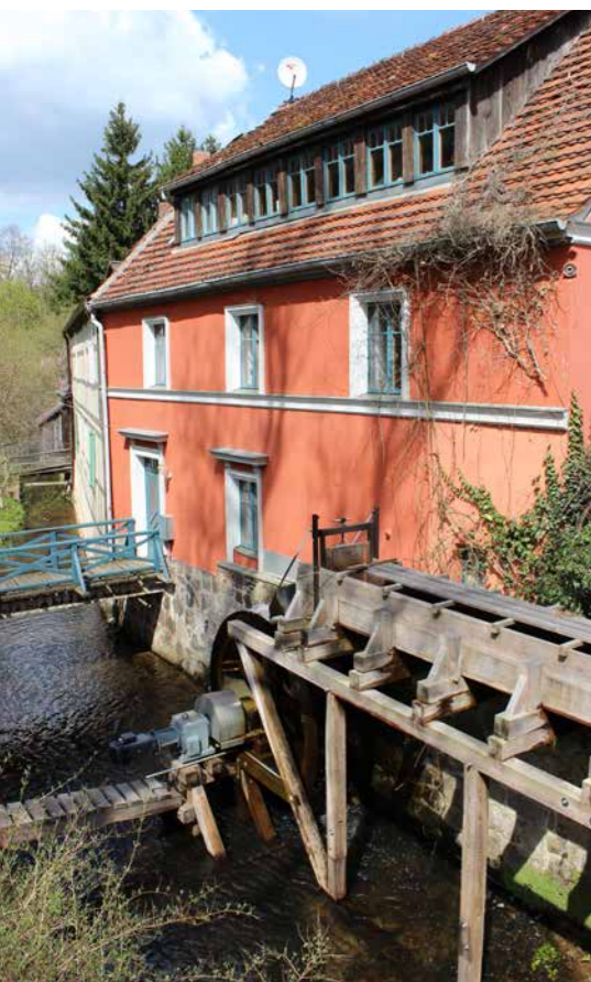
↓ Hermannsmühle Bardenitz – Denkmal mit modernem Wasserrad zur Stromerzeugung (Nr. 107)
