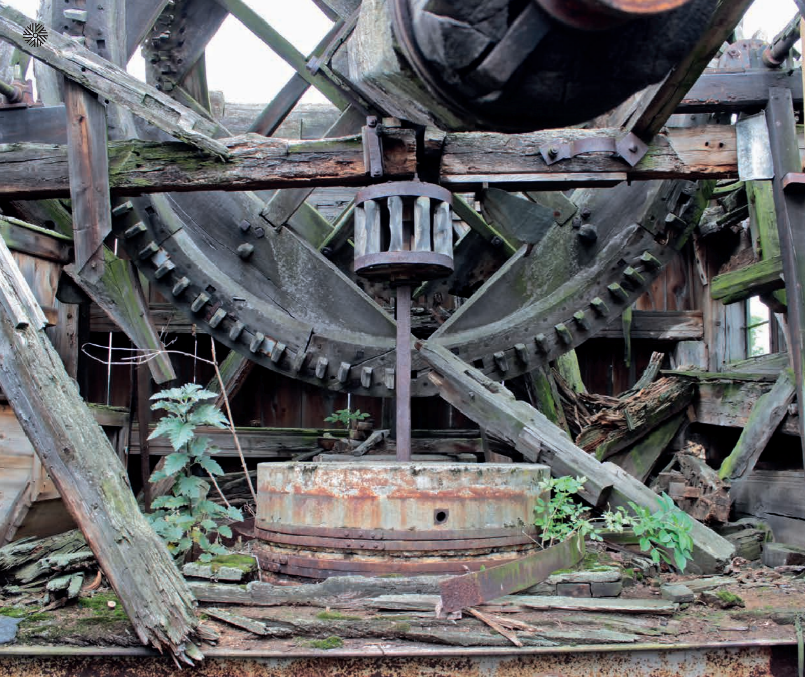
↑ Denkmalruine - die ehemalige Bockwindmühle Niendorf b. Dahme (Nr. 167) vor dem Abriss
