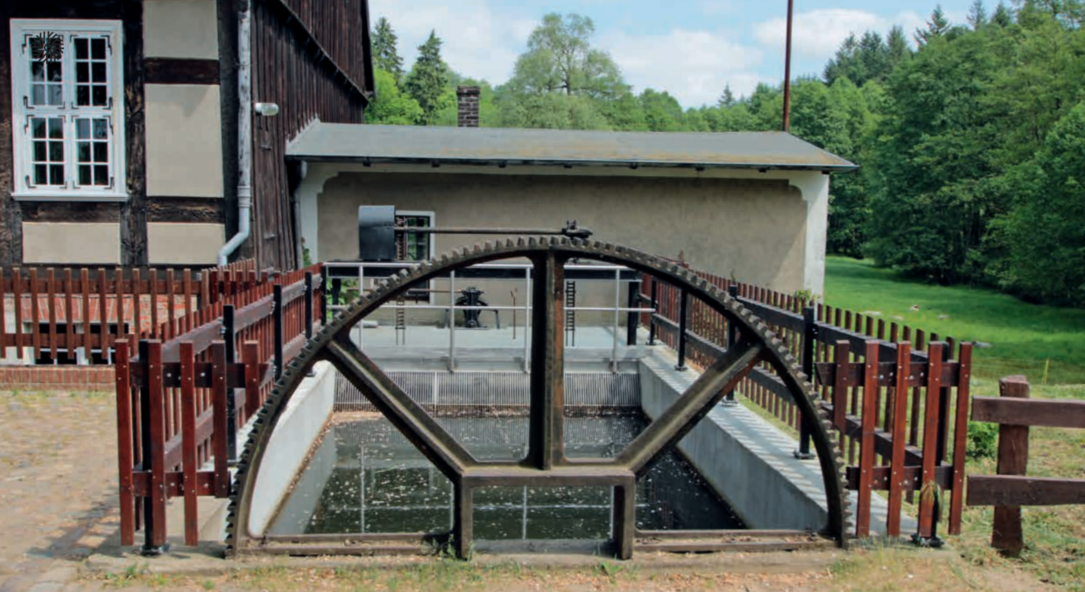
↑ Klostermühle Boitzenburg (Nr. 178) – Einlaufbereich zur Wasserturbine
