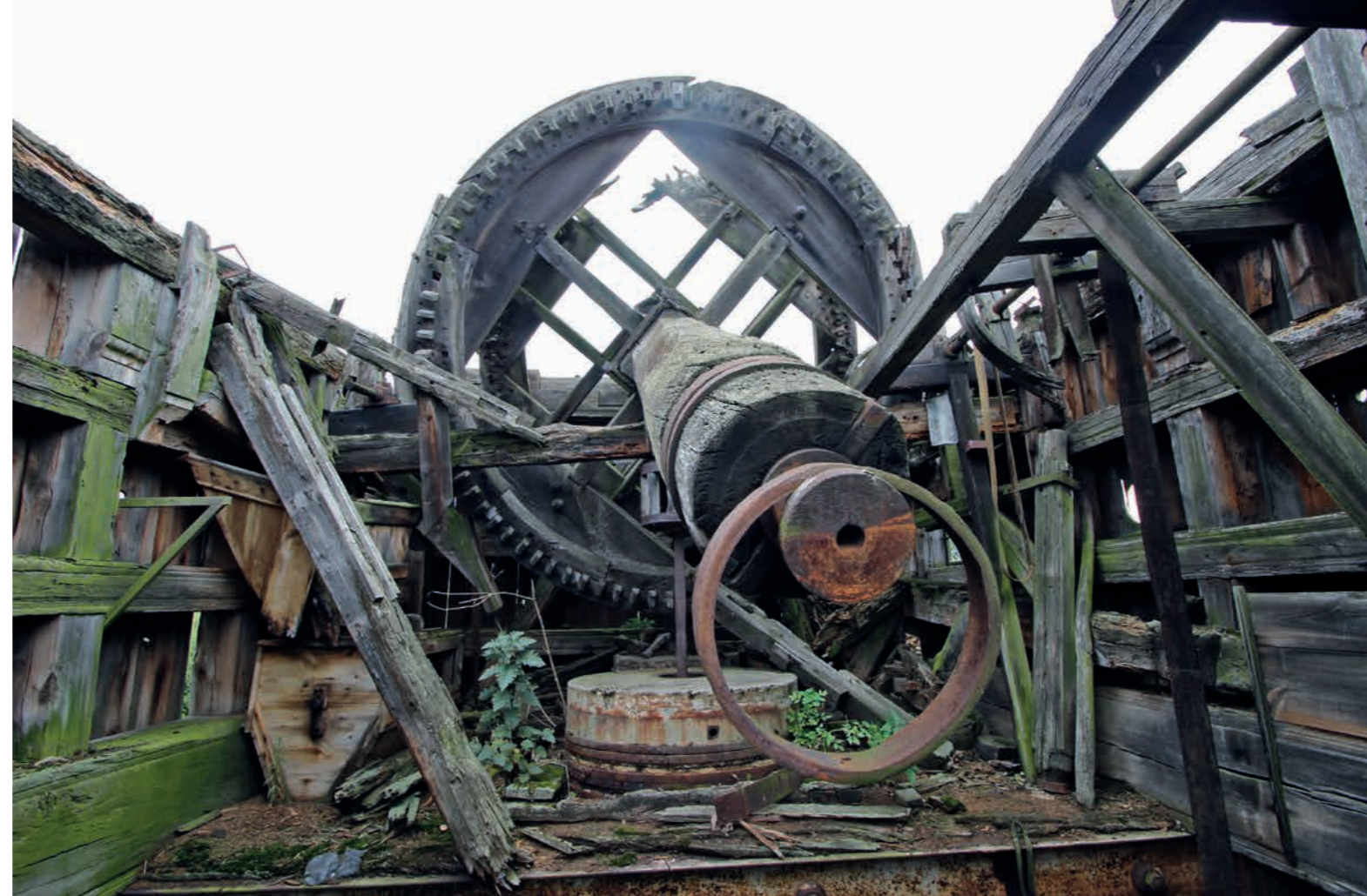
↑ Denkmalruine – Mahlboden und Flügelwelle mit Kamrad der ehemaligen Bockwindmühle Niendorf b. Dahme (Nr. 167) vor dem Abriss
