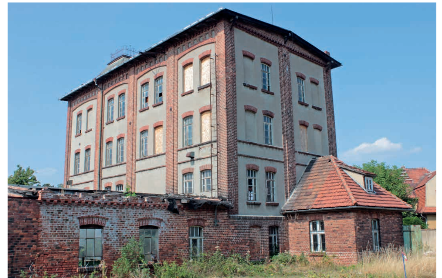
↓ Ehemalige Mühle Reimann Sonnewalde (Nr. 49) – Gartenseite mit Kontoranbau und Ölmühlenebengebäude
