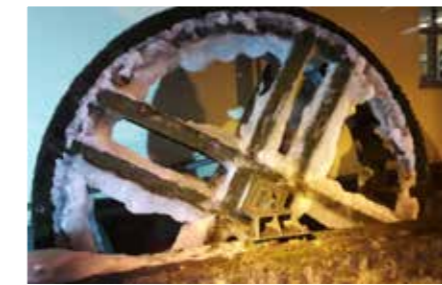
Das alte, marode Wasserrad vor der Demontage
