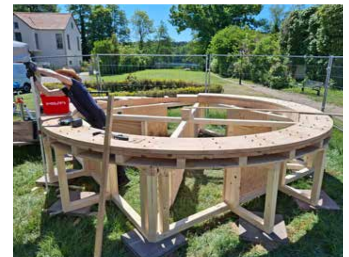
oben: Fertigung des neuen Wasserrads (LE)
