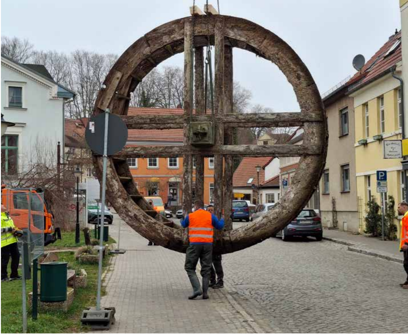
Demontage des alten Wasserrads in Buckow (LE)
